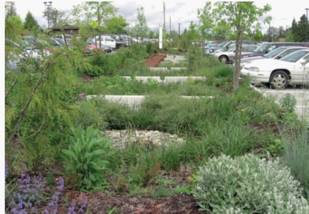
Imagen 19. Biorretención en camellón de estacionamiento.
