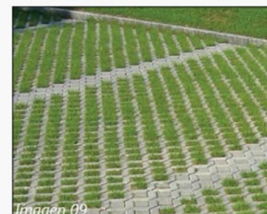
Adopasto de concreto
