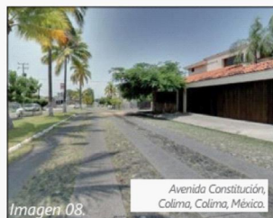
Empedrado permeable con huellas de rodadura vehicular
