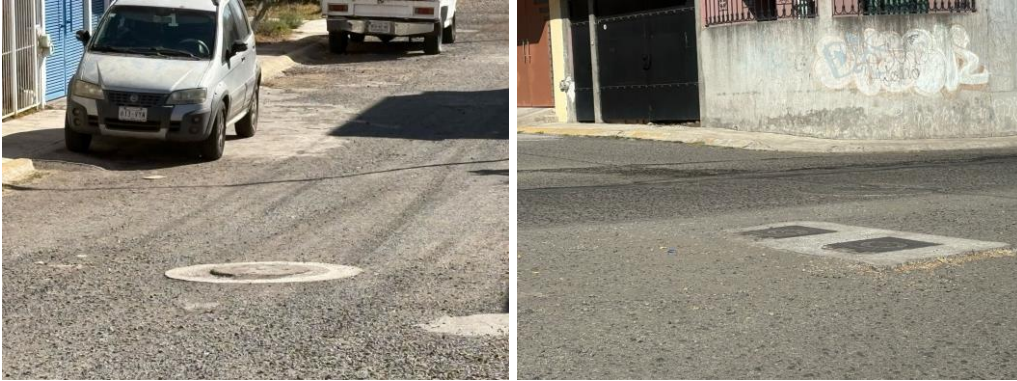
Figura IV.29. Infraestructura de agua potable y alcantarillado sanitario encontrado en las inmediaciones urbanas colindantes al predio (Fracc. Villa Magna). Fuente: propia.
