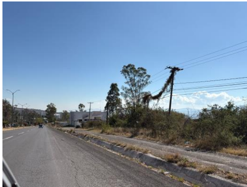
Figura IV.30. Red de alcantarillado pluvial y cunetas al borde de vialidad encontradas en la Carretera Federal 15, arteria principal en la zona. Fuente: propia.
