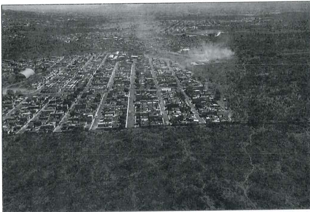
Figura. Vista del área en la que se muestra que las vialidades materia de la propuesta 3, son cerradas y delimitadas por una barda perimetral.
